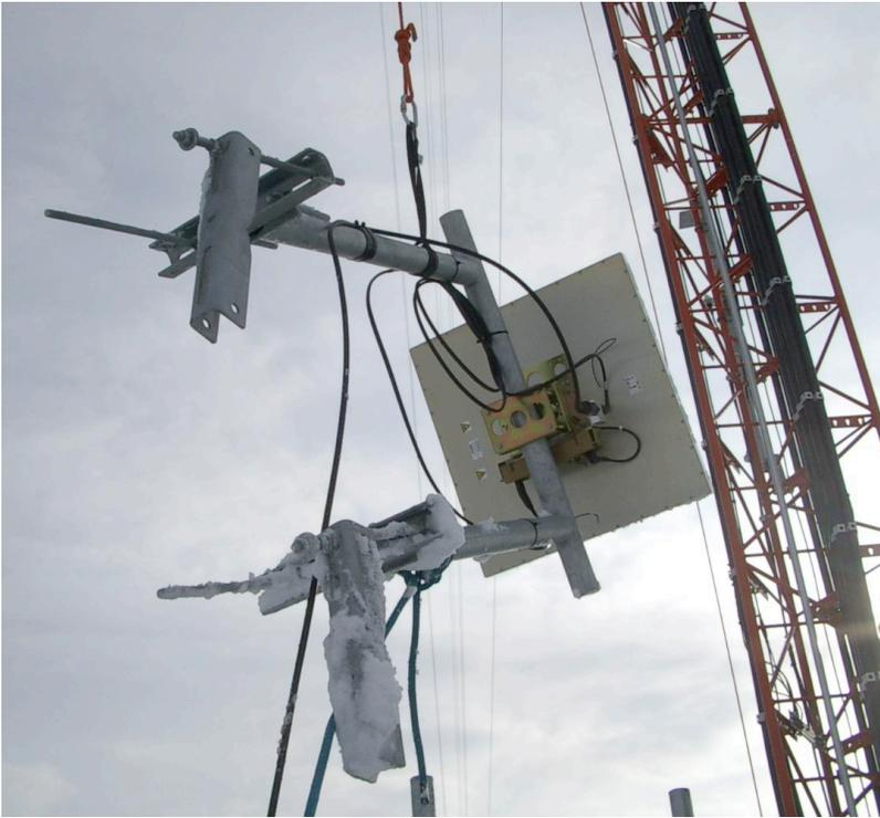
*Figura 7.1: Una antena con un soporte de separación instalándose en una torre.*
