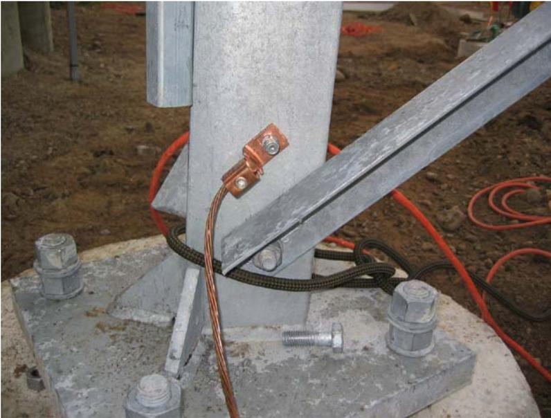
*Figura 5.2: Torre con un cable de cobre grueso conectado a tierra.*
