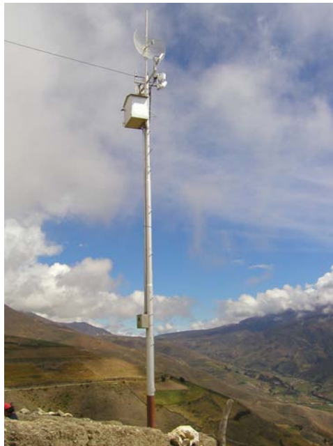
Figure 7.3: Une tour autoportante simple.
